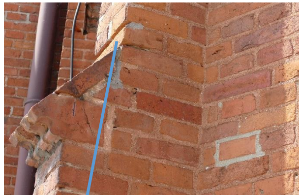
26,27,28,29. Zniszczone pulpity szkarp współcześnie zakrywane opierzeniami z blachy bez uprzedniej konserwacji cegły. Bruzdowanie oryginalnego lica elewacji.
