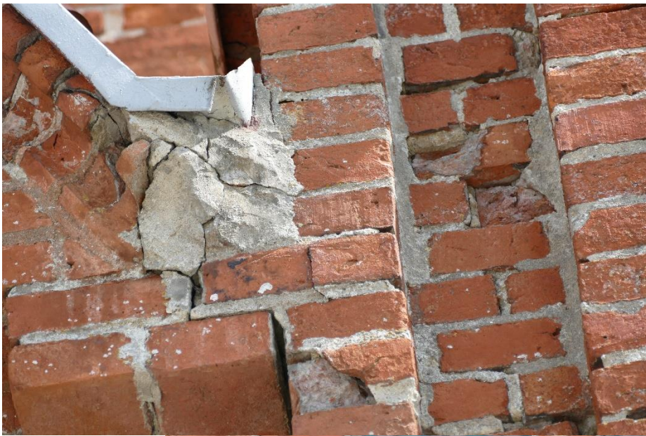
17. Wtórne spoinowanie zaprawą z dodatkiem cementu i pierwotne, wapienne, uwidocznione pod wykruszonym, wtórnym.
