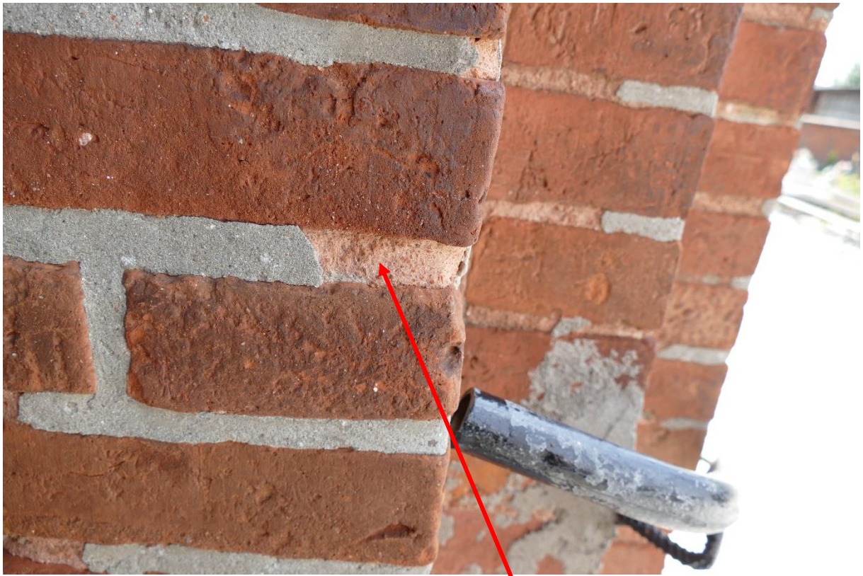
17. Wtórne spoinowanie zaprawą z dodatkiem cementu i pierwotne, wapienne, uwidocznione pod wykruszonym, wtórnym.
