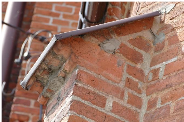
26,27,28,29. Zniszczone pulpity szkarp współcześnie zakrywane opierzeniami z blachy bez uprzedniej konserwacji cegły. Bruzdowanie oryginalnego lica elewacji.
